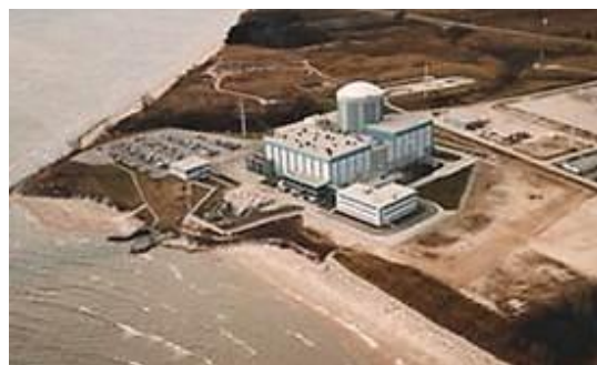
図1 キウオーニー原子力発電所の全景
