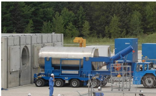
図 2 乾式貯蔵施設への燃料キャスク収容
