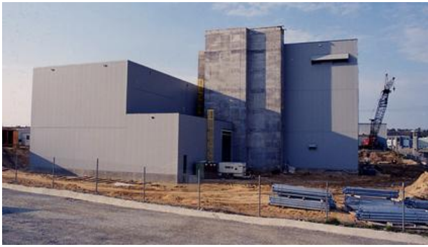
図2 Surry 発電所 総合廃棄物処理施設
