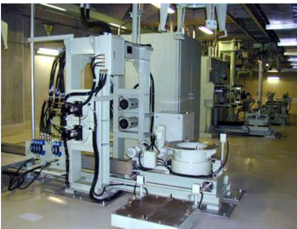
図3 廃棄体搬出検査装置
